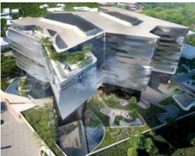
Sasol Head Office - Johannesburg (Południowa Afryka)
