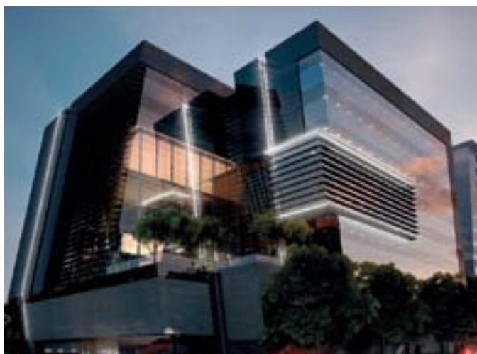
85 Greystone Building - Johannesburg (Republika Południowej Afryki)
